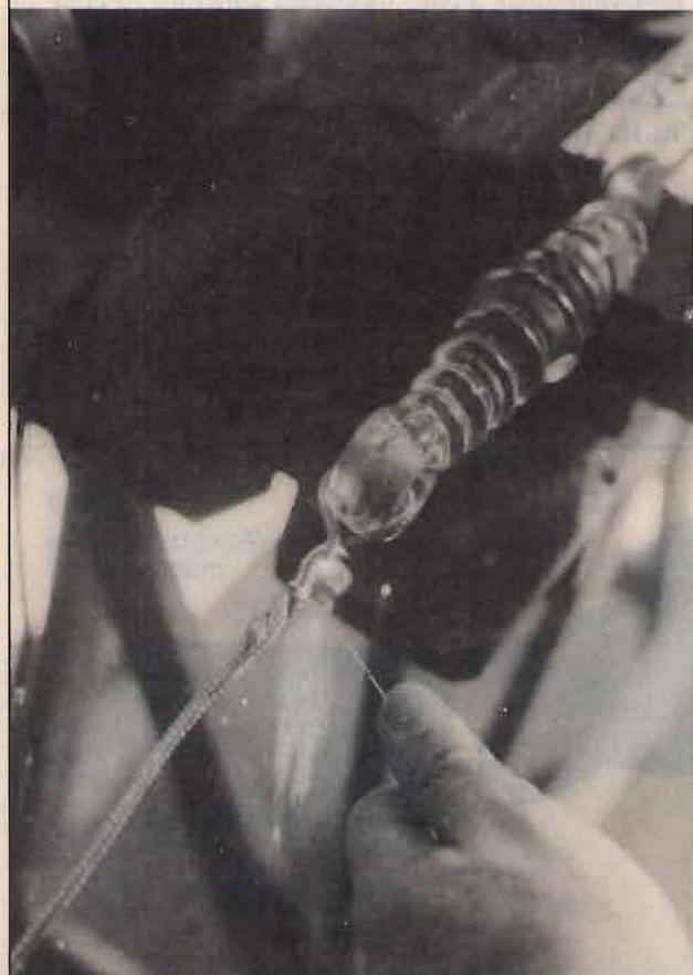
Per rendere più robusto l'attacco della treccia agli isolatori, occorre arrotolarla un paio di volte, e poi ricoprirla con sottile filo di rame nudo.
